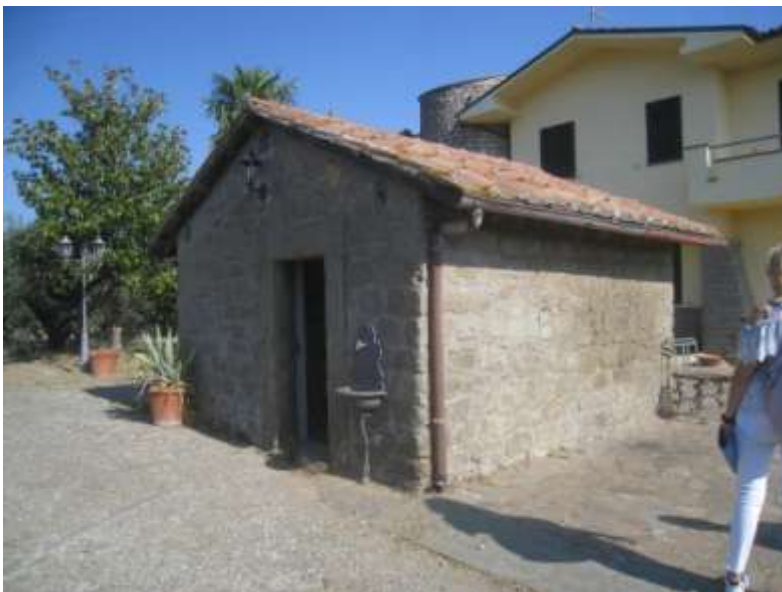
Foto 29 Ingresso locale interrato destinato a cantina
